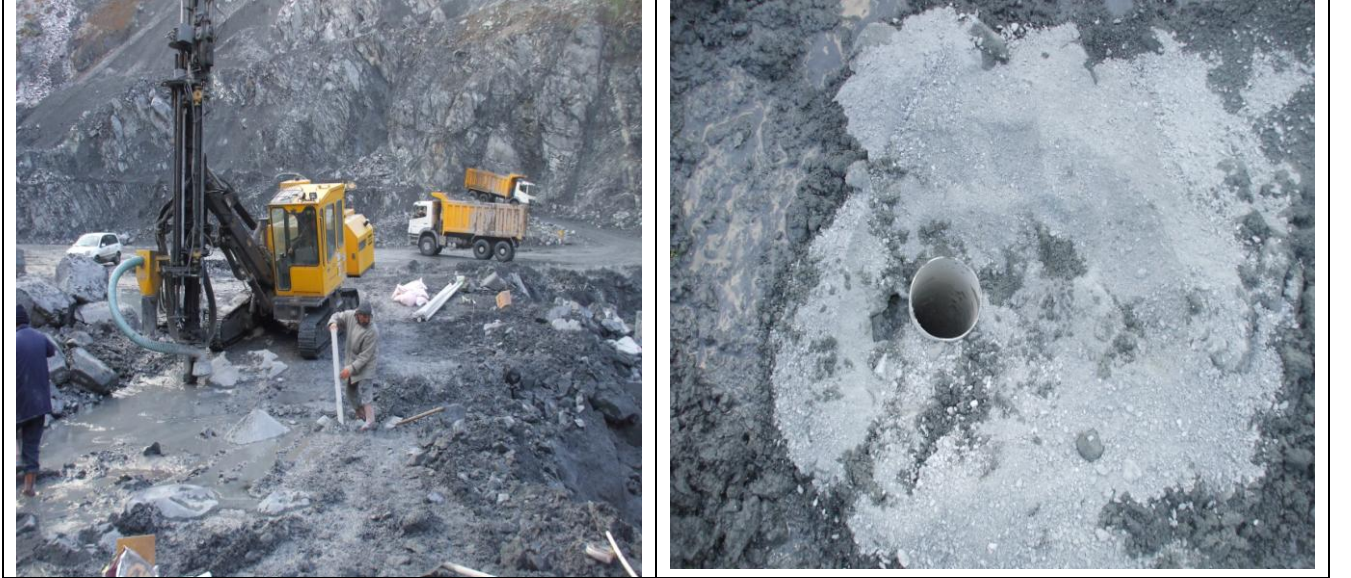
RESİM 3 – 102 mm çapında deliğe yerleştirilmiş 75 mm çaplı PVC borular.
