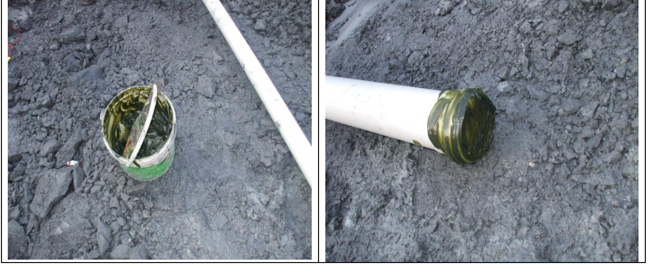
RESİM 2 – Boru dip kısmının gres yağı ile suya karşı izolasyonu
