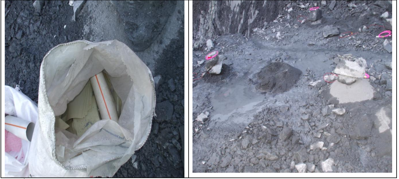
RESİM – 4 PVC boru içinde kullanılan folyo ve sıkılama sonrası delikler.
